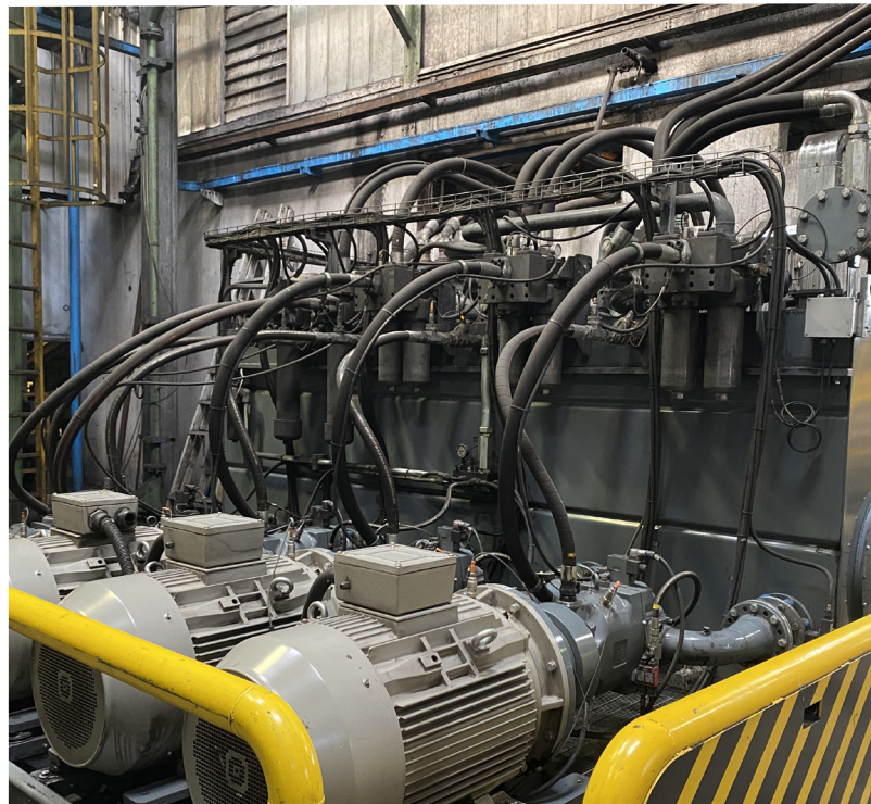
Centrale impianto di formatura con sistema di diagnostica integrato sviluppata da Oleobi per Fonderia Ghirlandina
